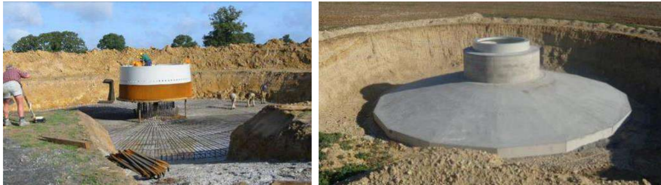
Photo 1 : Le ferrailage et le coulage d'une fondation d'éolienne
